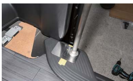
脚部分のステップ穴位置をマークする
